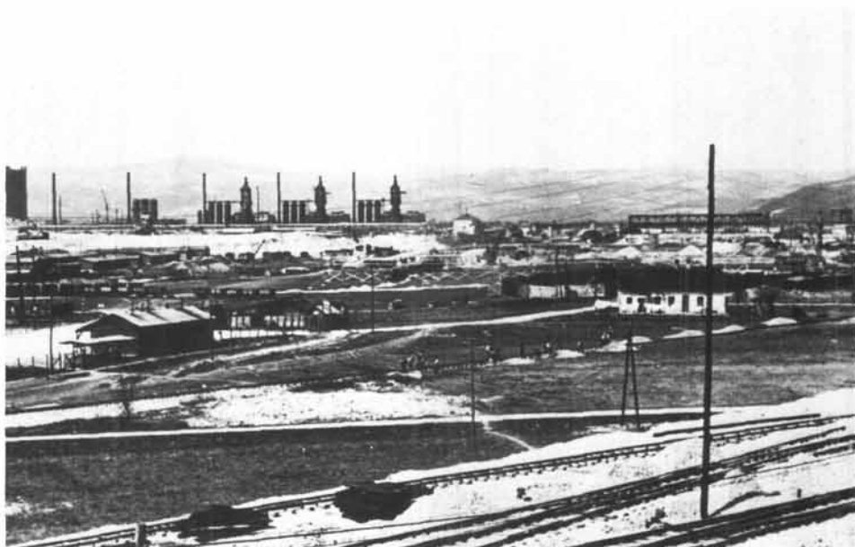
Oben: Der Bau der Hochofengruppe, Blickrichtung Norden, im April 1940.
