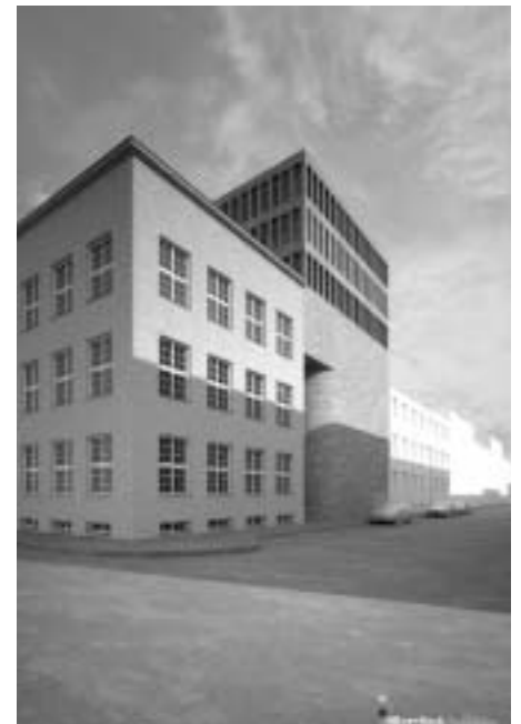
Außenansicht der in Bau befindlichen OÖ. Landesbibliothek
