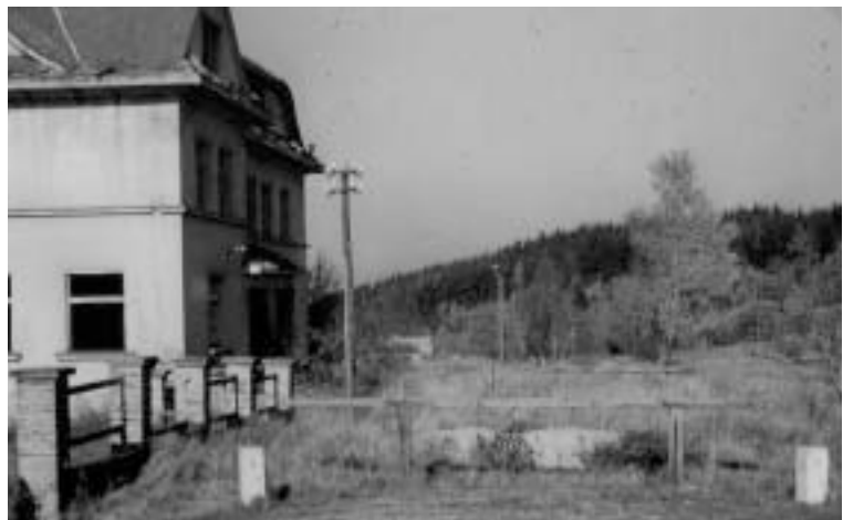
Das tschechische Zollhaus bei Weigetschlag im Bau, zirka im Jahr 1938 und vor dem Abriss Fotos: Werner Lehner
