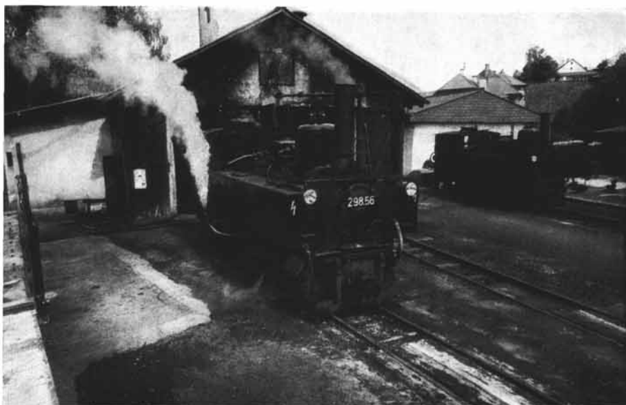
Abb. 4: Eine Maschine der Reihe U vor dem Heizhaus in Garsten.
