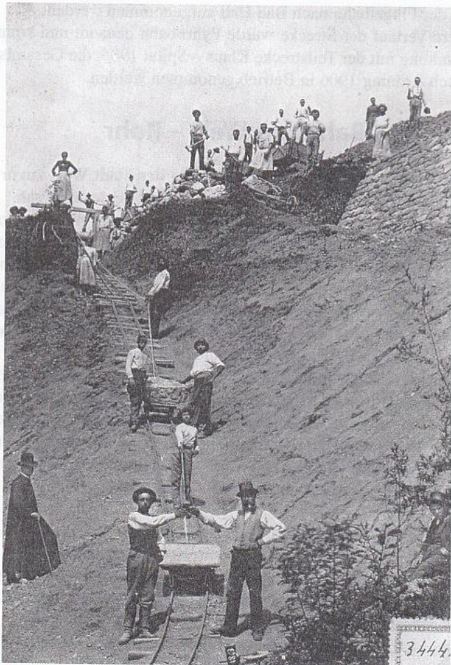
Abb. 1: Bauarbeiten am Damm der Welserbahn (Foto: Stadtmuseum Wels)
