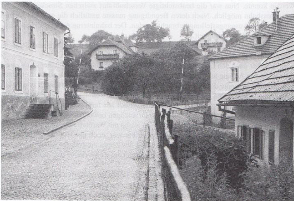
Abb. 24: Die Kreuzung mit der Sipbachzeller Bezirksstraße wurde im Bereich Sonntagberg durch Schranken gesichert. (Foto: Franz Rührlinger)
