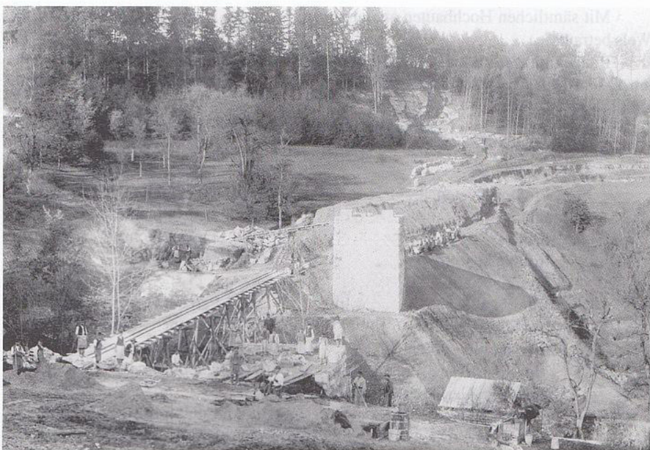
Abb. 2: Die Überquerung des Wolmersgrabens bei Kirchberg war eine der aufwendigsten Baustellen. (Foto: Stadtmuseum Wels)
