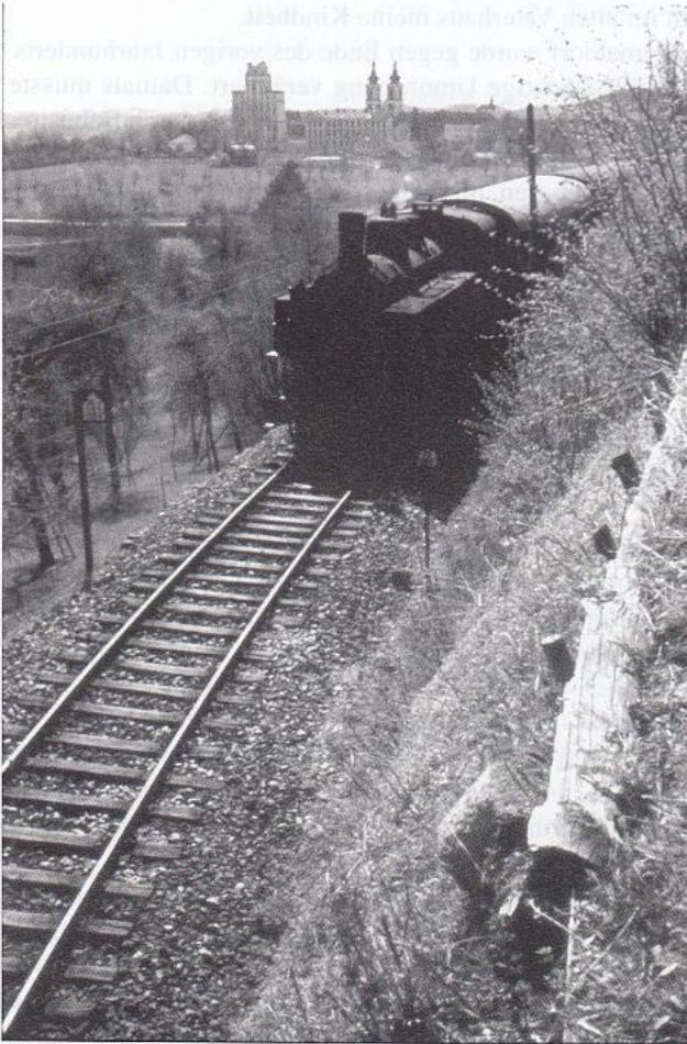
Abb. 43: Unterhalb der Volksschule Kirchberg taucht vor der Kulisse der Sternwarte, des Gymnasiums und des Stifts der Mittagszug Wels – Rohr auf. (Foto: Johann Müllner)
