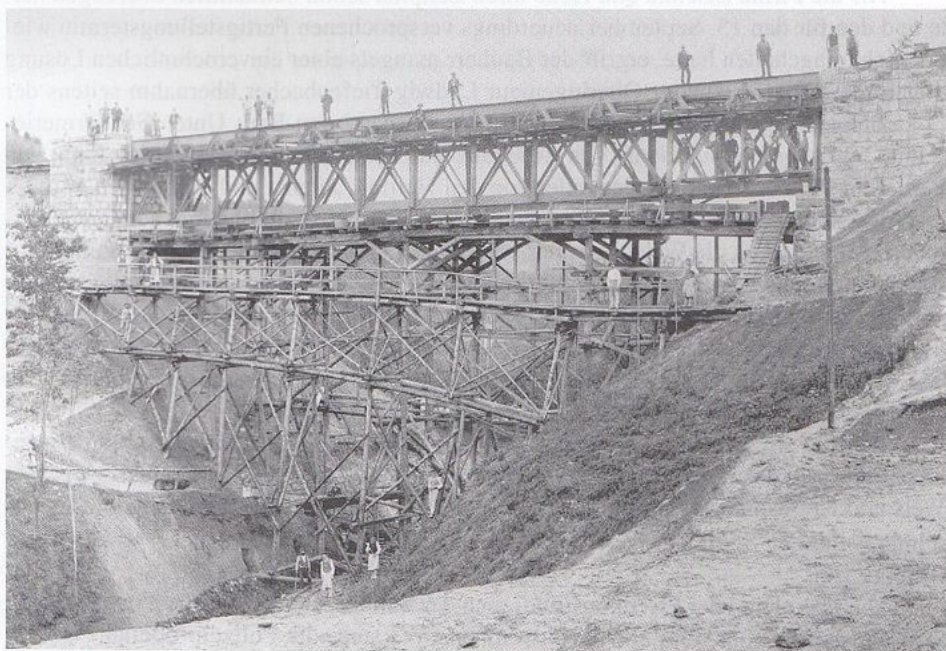
Abb. 3: Die Brücke über den Wolmersgraben knapp vor der Fertigstellung (Foto: Stadtmuseum Wels)
