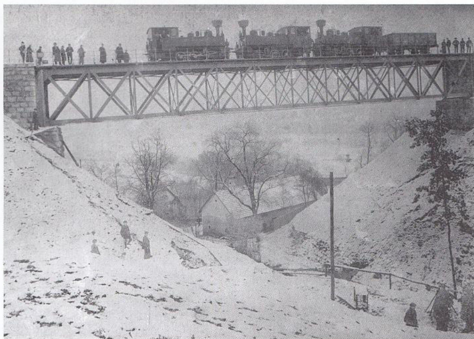
Abb. 4: Am 18. November 1893 war das Teilstück Kremsmünster Stift – Unter-Rohr fertig. Belastungsprobe der Brücke bei Kirchberg (Foto: Johannes Strauß)
