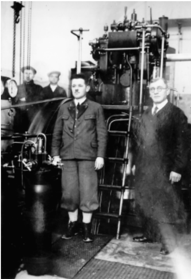
Das 1925 im Abteitrakt errichtete Dieselaggregat. Im Steireranzug der Leiter des E-Werks, Herr Siegfried Oder sen., geb. 1902, rechts von ihm der Monteur Josef Huber von der Leobersdorfer Maschinenfabrik.
