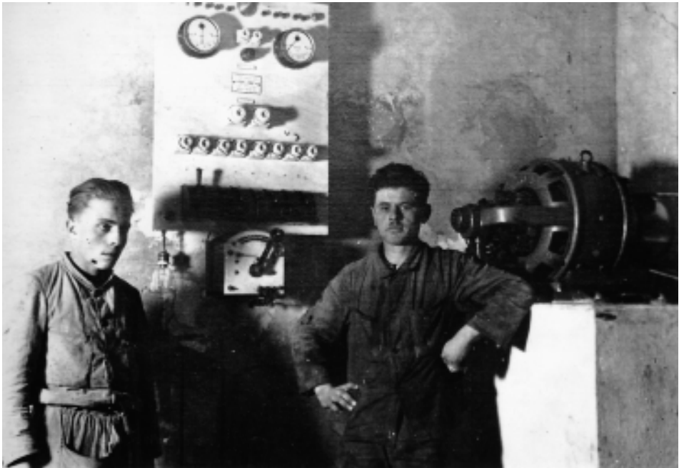
Herr Siegfried Oder zwischen „Normalschaltplatte auf Marmortafel“ und dem Dynamo des Dieselaggregats.
