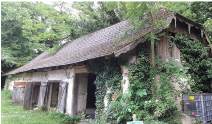
Abbildung 23: Feigenhaus und Nebengebäude vor der Restaurierung 2015 (Alfred R. Benesch © 2015)
