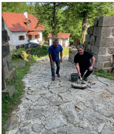
Aufgang zur Ruine ausbessern und ausfugen, Karl Leuchtenmüller und Karl Aigner
