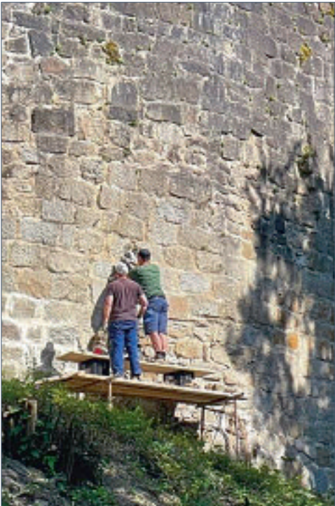
Sanierungs- und Reparaturarbeiten an den Außenmauern der Burgruine,...
