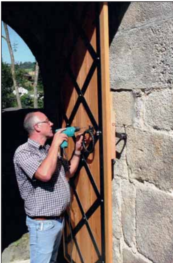
2008: Fachkundige Montage des Burgtores, Tischlermeister Helmut Redl
