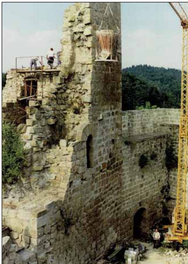
Walter Hölzl im Burghof an der Kransteuerung
