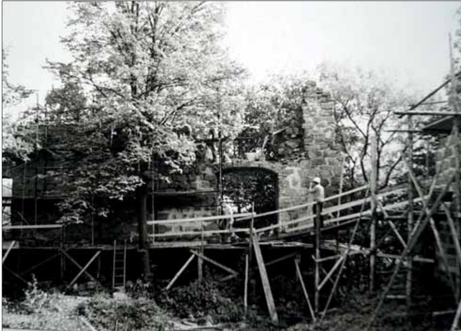
Die gleiche Süd-West-Ecke Beginn der Arbeiten in diesem Abschnitt...
