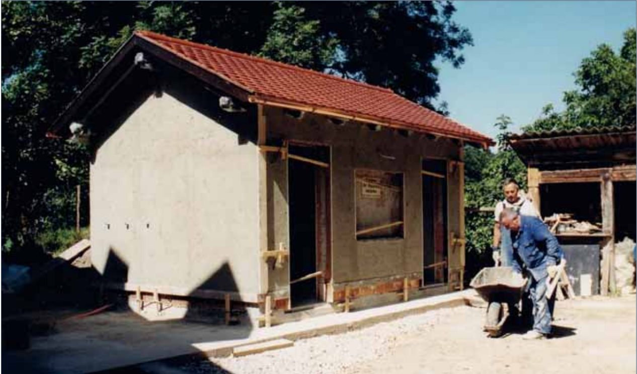
Fertigstellung der Sanitäranlage
