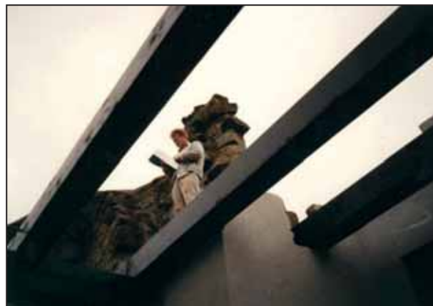
Einziehen der Holzdecken im Bergfried, J. Haneder
