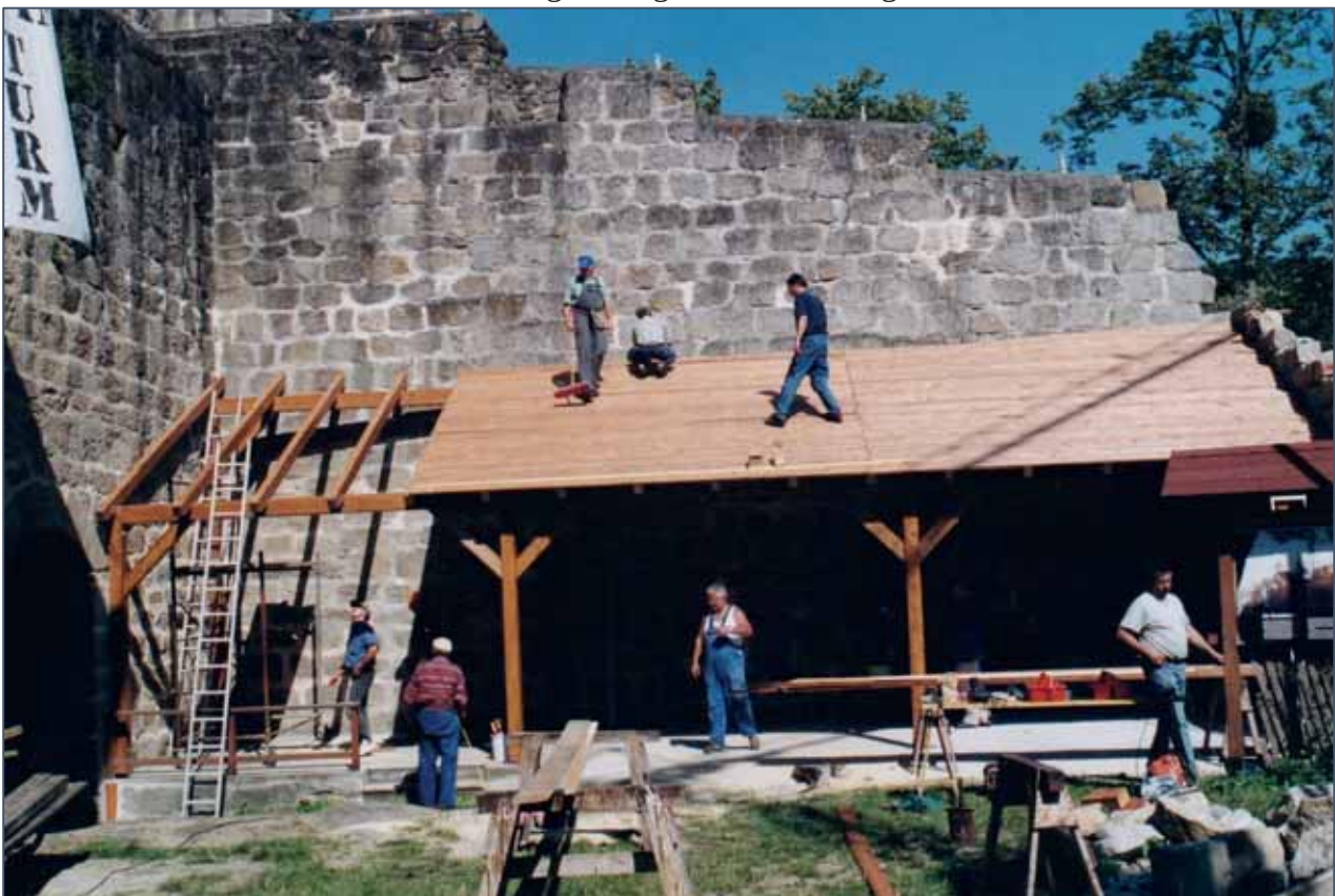
2004 – die überdachte Sitzfläche im Burghof wird errichtet
