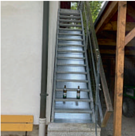
Schutzblech unter der Stiege montieren: Keplinger Michael und Leitner Christian
