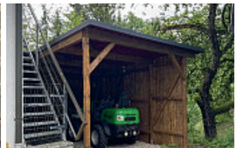
Licht im neuen Unterstand installiert: Stöger Hans
