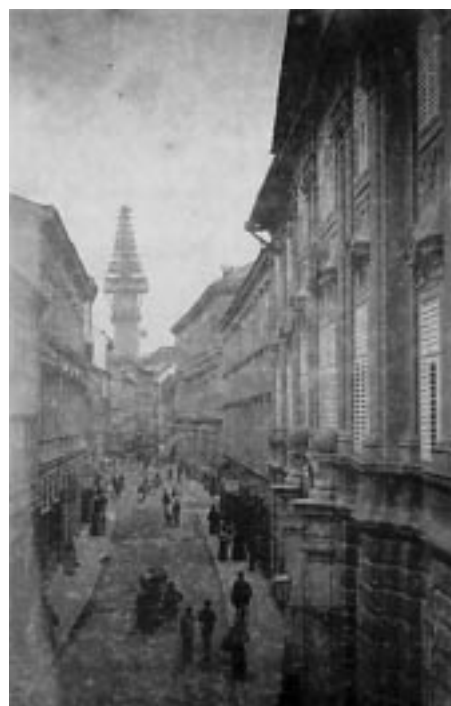
Blick durch die Herrenstraße auf den eingerüsteten Landhausturm 1911
