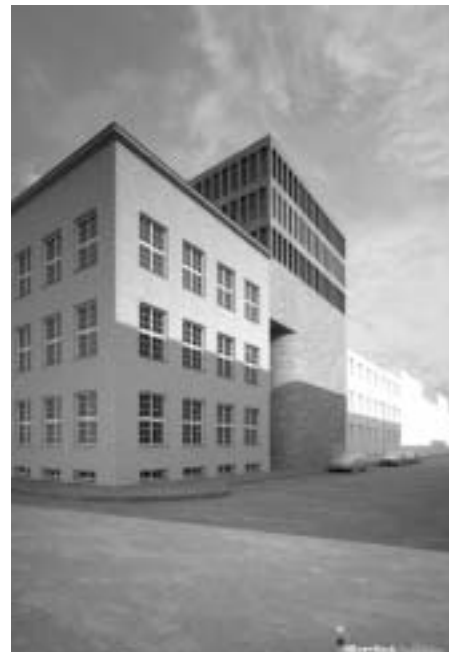
Außenansicht der in Bau befindlichen OÖ. Landesbibliothek
