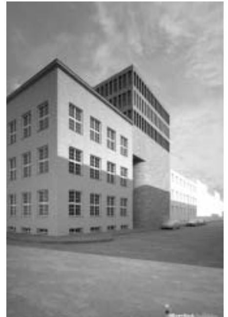
Außenansicht der in Bau befindlichen OÖ. Landesbibliothek
