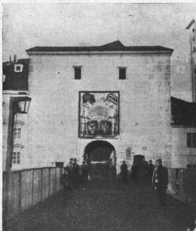
Abb. 4: Das Ennstor vor dem Abbruch im Jahre 1864. Lichtbild im Heimathaus Steyr Lichtbilder Eßleßbichler
