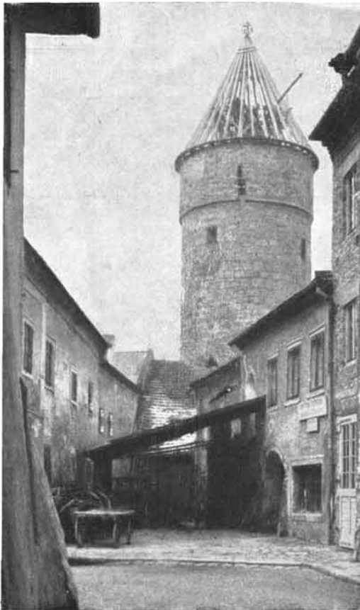
Die Reste alter Stadtbefestigungen werden nur selten so vorbildlich gepflegt wie in Freistadt (Eindeckungsarbeiten am Scheiblingturm)
