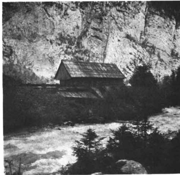
Abb. 2: Die alte Riezinger-Steinmühle im Echerntal. Sie stand unweit des Gasthauses „Zur grünen Wiese“ am linken Waldbachufer und erhielt durch einen Fluder, der ein gutes Stück bachaufwärts ansetzte, das nötige Wasser für das unterschlächtige Mühlrad. Zur Einrichtung gehörte eine Steinsäge, der aus einem Trichter Wasser und Sand zuflossen sowie eine große Drehbank. 1917 war bereits alles dem Verfalle preisgegeben. Heute stehen nur mehr Reste der steinernen Grundmauern
