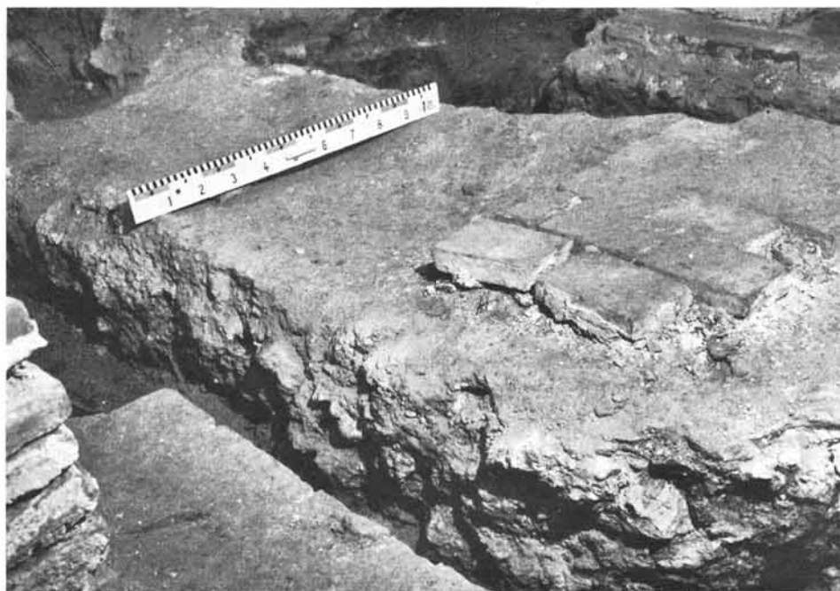
Abb. 5: Fundamentmauer B, W-Wange
