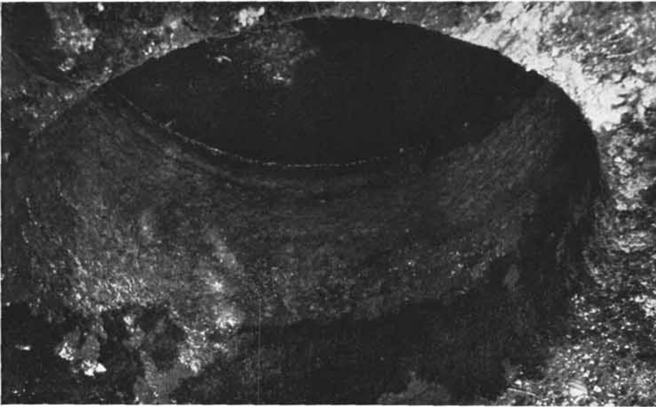
Die zisternenartige Ausmeißelung auf einer Felsplatte nordwestlich des Ortes Luftenberg (Gründungsloch für den Hausbaum der Windmühle)
