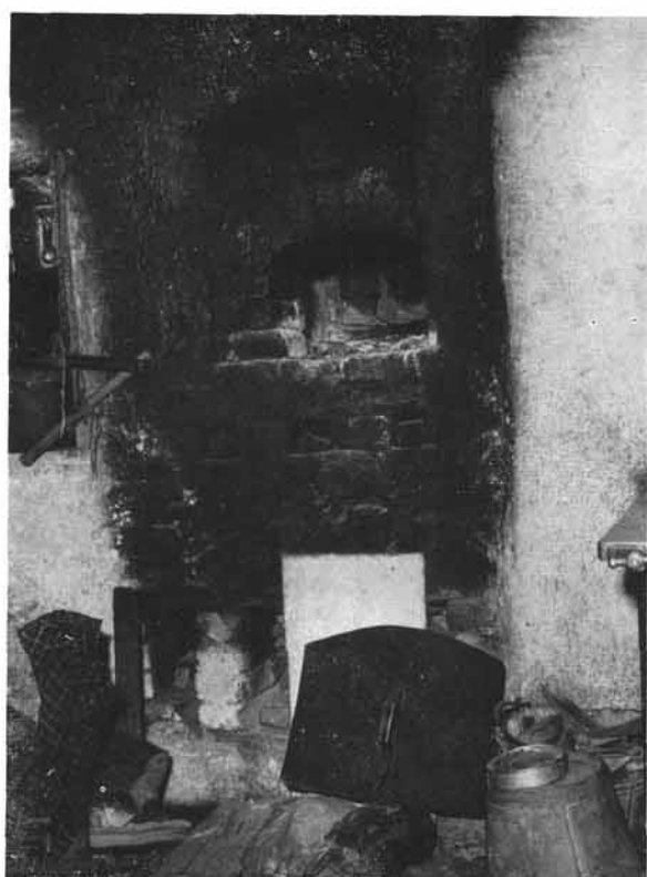
Bild 5: „Schwarze Küche“. Oben Heiz- und Rauchabzugsöffnung für den Stubenofen: unten Backofen- und Beleuchtungsöffnung, darüber 3 viereckige Rauchabzugsöffnungen, durch Steine verschlossen. Vor dem Backofen Verschlussblech für diesen (geweißt) und für die Herdöffnung. Links Wandnische
