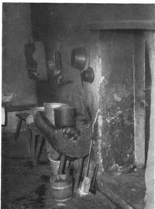
Bild 4: Ecke der „schwarzen Küche“ neben der Stalltür. Oben hölzerne Rinne zur Wasserzuführung in den Kessel. Hölzerner Granter auf Holzbeinen, Stück der Wandbank. Das Natursteinpflaster der Küche liegt um 60 cm tiefer als der Boden des Vorhauses, von dem 4 Stufen in die Küche führen
