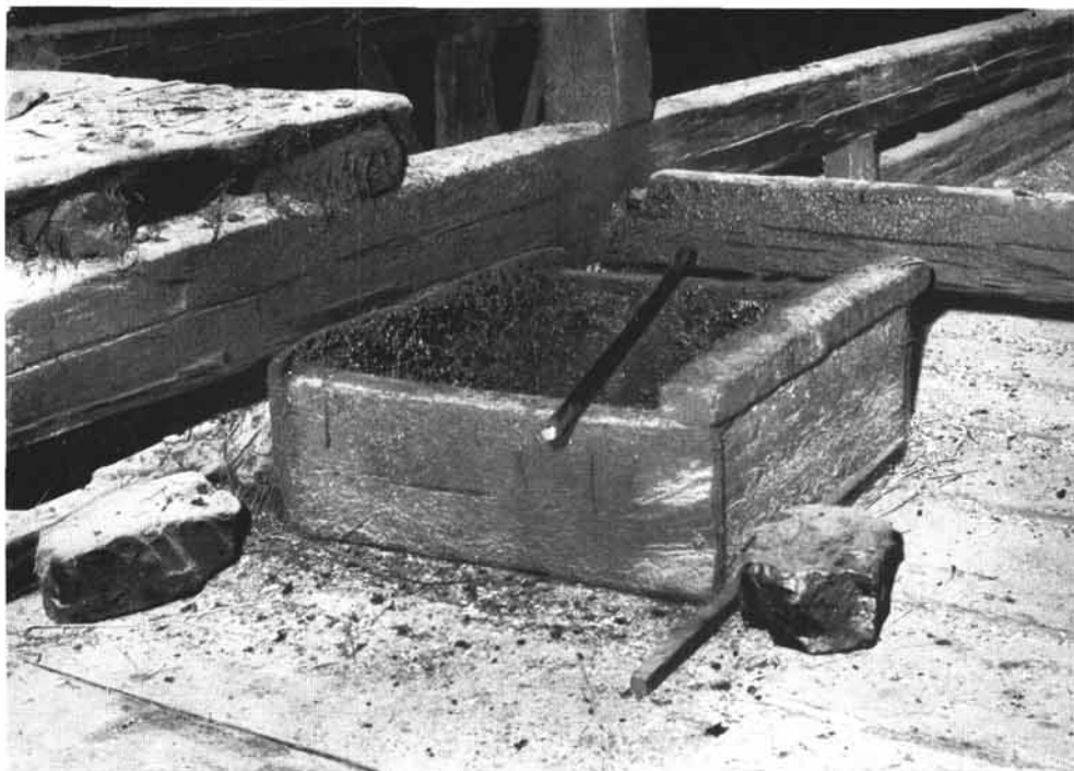
Bild 4: Rauchabzugsöffnung im Dachboden. Kienruß an der Innenseite und danebenliegenden Balken. Stock zum Auf- hängen von Selchfleisch.
