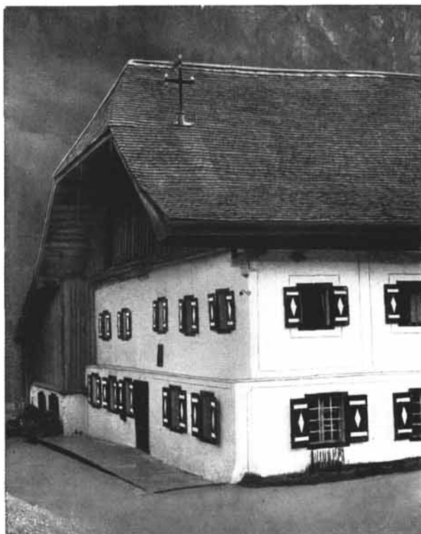
Bild 1: Erbhof Pointinger, Fellerhut in Au 5, Gemeinde Unterach. Erdgeschoß Steinmauer; Obergeschoß Holz, verputzt. Steildach mit Schopf von 1851. Stall 1781 an der Südseite angebaut.
