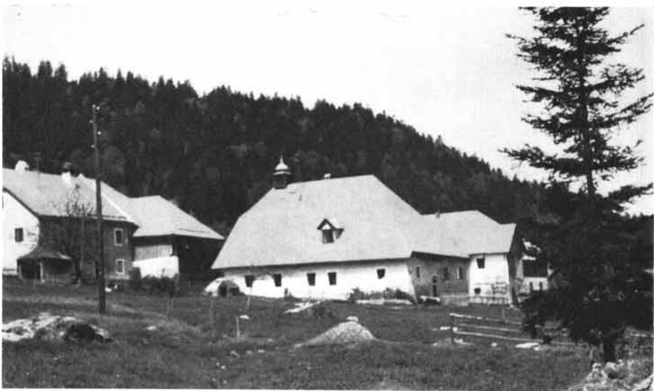
2 Hacklbrunn: Ehemaliges Badhaus (rechts) und Gasthaus (links). Vor dem Badhaus das „Quellhüttel“
