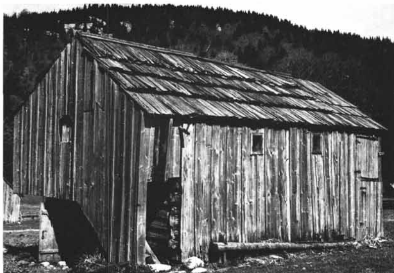
Abb. 26 Ausseer Übereinandhütte. Auf- gelassene Hütte auf Blaalm. Trepeltür offen. Ganze Hütte, einschließlich Aufgang, „Hütte“ senkrecht mit Brettern verschalt. Stiegenansatz und Rundholzbau sichtbar, ebenso Ausschnitt in Schalung zur Eingangstür in Hütte, je ein kleines Fenster in die Hütte und Bettkasten. In der Hütte kleiner, offener Herd (kein Kamin!). Steiles Sattel- dach mit knappem Vorsprung mit Langschindeln gedeckt. Hinten untere Tür zum Abtritt, oben für kleinen Heuboden.
