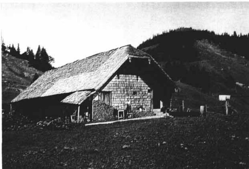
Abb. 24: Illingberg, Weiderhütte; Wolfgangsee „Hintereinanderhütte“. Abgeschöpftes Schindeldach, Giebelwand und Seitenwände verschindelt. Eingangstür offen. Linke, mit Brennholz verstellte Tür zeigt, daß die Hütte ursprünglich Nebeneinanderhütte war und dann unter dem Einfluß der benachbarten Hintereinanderhütten zu solcher umgebaut wurde.
