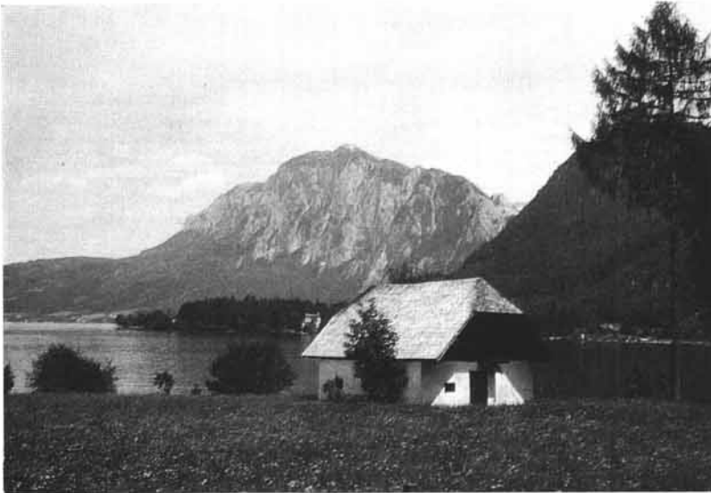
Abb. 23: Einstige Rechenstube unweit des Burggrabenrechens am Attersee. Der Holzersparnis wegen gemauert. Durch das große, abgewalmte Dach eindrucksvoller „Zweckbau“ der Alten. Seidenglanz des Schindeldaches. Die Erhaltung des Gebäudes in ursprünglicher Art ist dem Besitzer, Herrn Dr. Rudolf Nementschke, zu danken.
