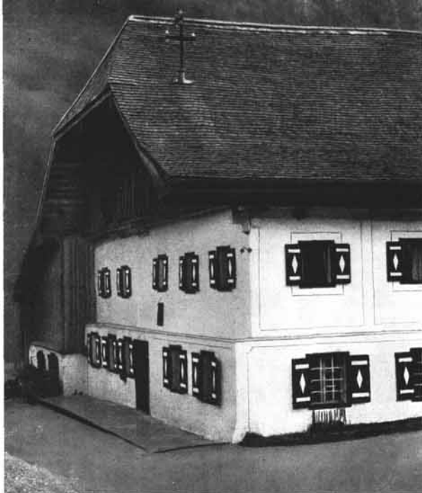
Abb. 19: Haus Pointinger, Unterach, Au Nr. 5. Ehemaliges Flurküchen- haus mit zweiter Feuerstelle im Obergeschoß. Der Rauch wurde durch einen hölzernen Schlot in den Strohboden geführt, von dem aus er zwischen den Schindelfugen abzog. Schlotaus- tritt durch Holzkranz umfassen. Auf den Stock wurde Fleisch zum Räuchern gehängt.
