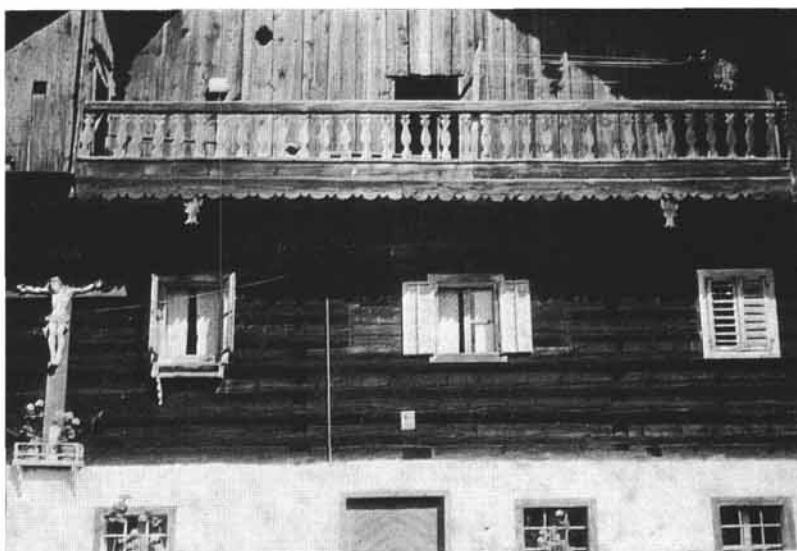
Abb. 27: Früheres Rauchküchenhaus Lechner, Rabenschwand 58, Gmd. Oberhofen. Sehr schöne Zimmermannsarbeiten. Man Be- achte die verschieden ausgeform- ten Köpfe (Verzinkungen) der Riegelwand.
