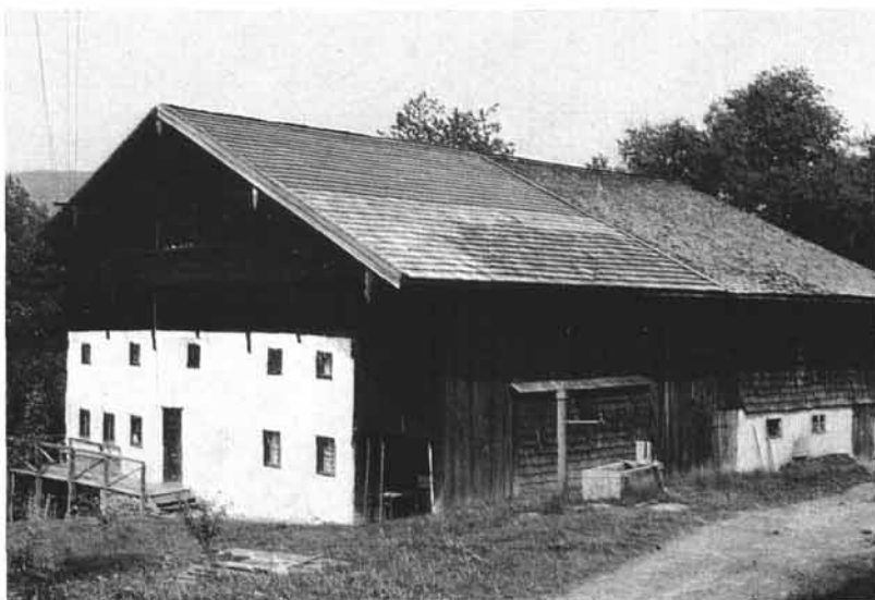
Abb. 21: Unterer Tiefgraber, Tiefgraben Nr. 1. Blockbau, verputzt, Stall gemauert, Seitenwand mit Bret- tern und Schindeln verschalt. Gewandgang mit gedrehten Säulen. Schindeln teilweise durch Dachziegel ersetzt. Heute noch Rauchhaus.
