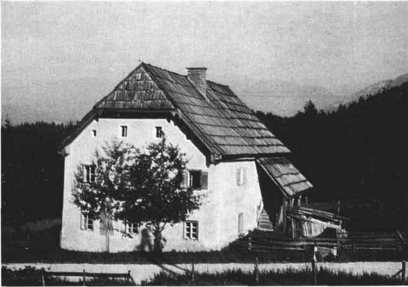
Abb. 7: Altes Wegmacherhaus auf o.ö. Seite des Pötschenpasses; ge- mauert. Steiles, mit Brettern ge- decktes Schopfdach. Gesonderte Eingänge in die Wohnungen der beiden Wegmacher. Rechts über- dachter Aufgang ins Oberge- schoß. Dach des Brunnenhäusels eingefallen.
