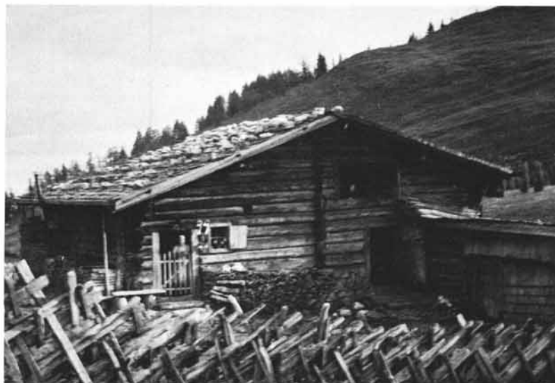
Abb. 25 Wiesleralm, Lindentalhütte, Osterhorngruppe. Abtenauer „Nebenandhütte“ aus Rundholz, Legschindeldach. Links Hütten- eingang offen, auch mit Gatterl verschießbar, damit das aus der Stalltür kommende Vieh nicht in die „Hütte“, den Wirtschafts- raum, treten kann. Über der Stalltür Luke in den Heuboden. Die Vorköpfe der Trennwand zwischen Hütte und Stall zeigen, daß der Stall größer als die Wirtschaftsräume sind. Sta- keten(Spelten)zaun.
