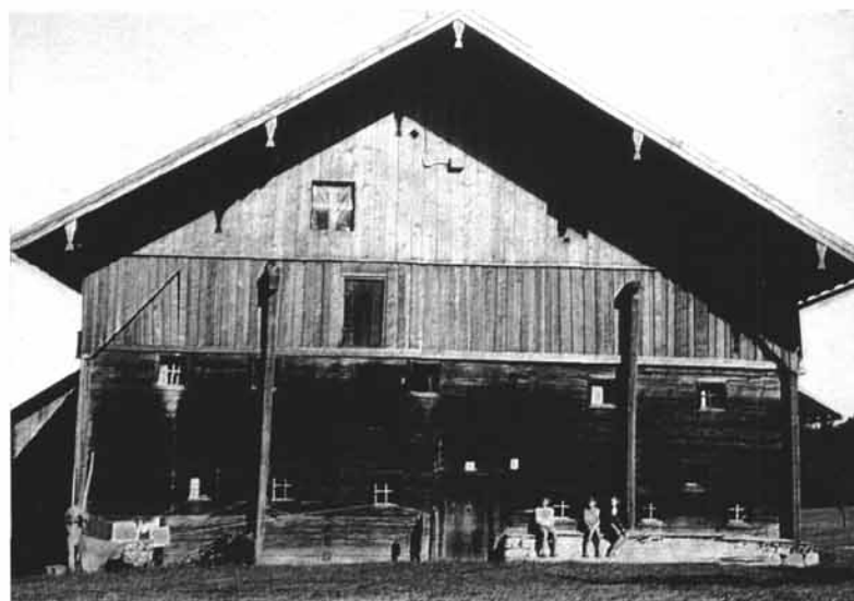
Abb. 18: Firlinger, Laiter 34, Gmd. Ober- hofen. Rauchküchenhaus, in Stube rechts Rauchabzugsfenster über Stubenfenster, ein zweites an Ostseite (rechts) zugeschalt. Links ober Haustüre Rauch- abzugstür. Ehemaliges Rauch- stubenhaus? Aufsteilung 1964.
