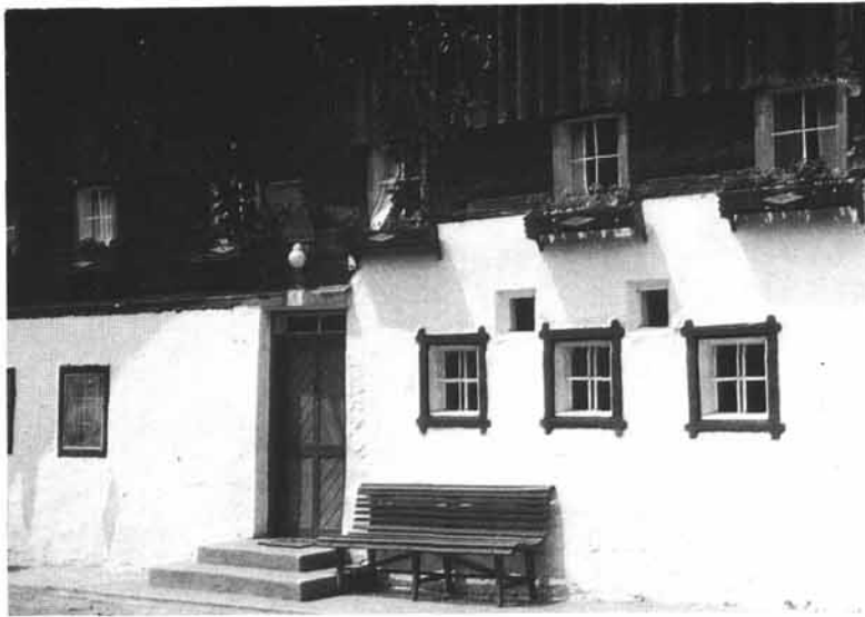
Abb. 16: Kleinbauernhaus Fellner, Schmiedhuber, Gaisberg 6, Gmd. Tiefgraben. Ehemaliges Rauch- haus mit 2 Rauchabzugsfenstern oberhalb der Stubenfenster. Blockbau im Erdgeschoß durch Mauerwerk unterfangen.
