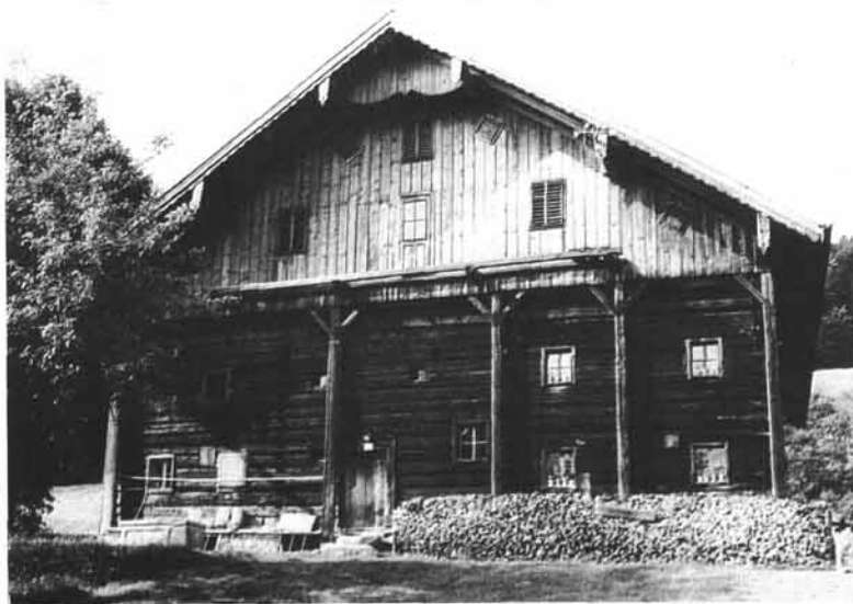
Abb. 17: Breitentaler, Tiefgraben 45. Stattliches Gehöft, heute noch Rauchhaus. Rauchabzugsfenster in Stube rechts, ein zweites an der Ostseite (rechts) mit Brettern verschlagen, ebenso verschlossen ist ein solches in der Stube links. Dachaufsteilung, Hengste, Ober- geschoß für Ausbau vorbereitet.
