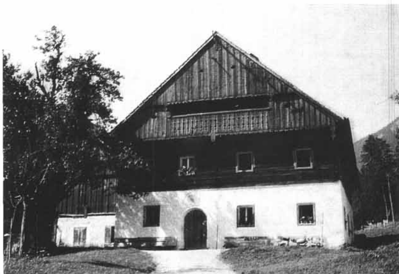
Abb. 5: Gosau, Zwiefhof. Erdgeschoß ge- mauert, darüber Blockwände; steiles Satteldach, Gewandgang, Zierläden, Giebfeld senkrecht verschalt. Links hinten Stall- stadel, Stall gemauert.
