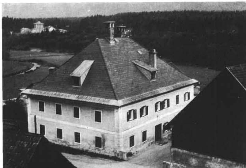
Abb. 4: Miesbachmühle, Steinkogel, Ebensee. Schon 1447 erwähnt; gemauert. Einst Mühle und Sägewerk, heute Sägewerk. Paar- hof. Mühle — stattliches Voll- walmdach, regelmäßige Fenster- anordnung, Stallstadel im Erd- geschoß gemauert.
