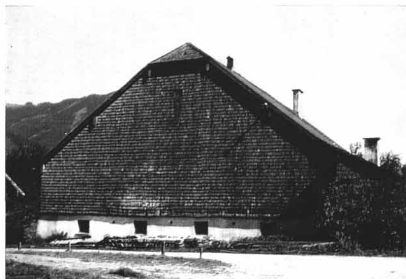
Abb. 12: Schindelmantel (Bsetz) mit knappem Dachvorsprung auf (West-)Wetterseite und ein diesem entsprechender kleiner Schopf (Achtelschopf).
