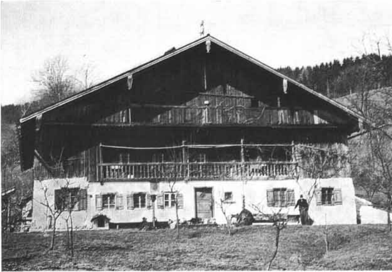
Abb. 13: Faschingergut, Kneißl, Unter- ach. Aufsteilung vom Leg- schindeldach zum mittelsteilen Satteldach (Halbreschen). Erd- geschoß gemauert, Obergeschoß Blockbau, in seitlichen An- bauten senkrecht verschalt. Zwei Gewandgänge. Einhaus. Schönes Beispiel für ein „wachsendes“, vergrößertes Haus, das unter dem neuen, vergrößerten Dach symmetrisch ist und ruhig und stattlich wirkt.
