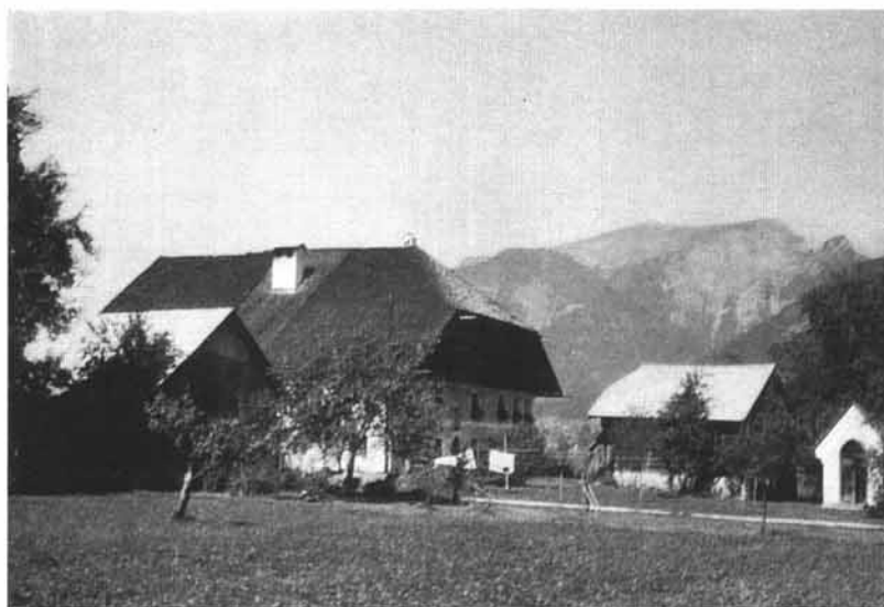
Abb. 10: Nestnerbauer, Unterberger, Strobl 2. Dachaufsteilung 1769. Ideale Größe und Steilheit des Schopfes noch nicht gefunden; zu groß und zu flach, über den Dachvorsprung in den Dachbo- den greifend. Wolfgangseer Ein- haus mit 2 m breitem Dach- vorsprung an Giebelseite. Ge- wandgang. Hintergrund: Schaf- berg.
