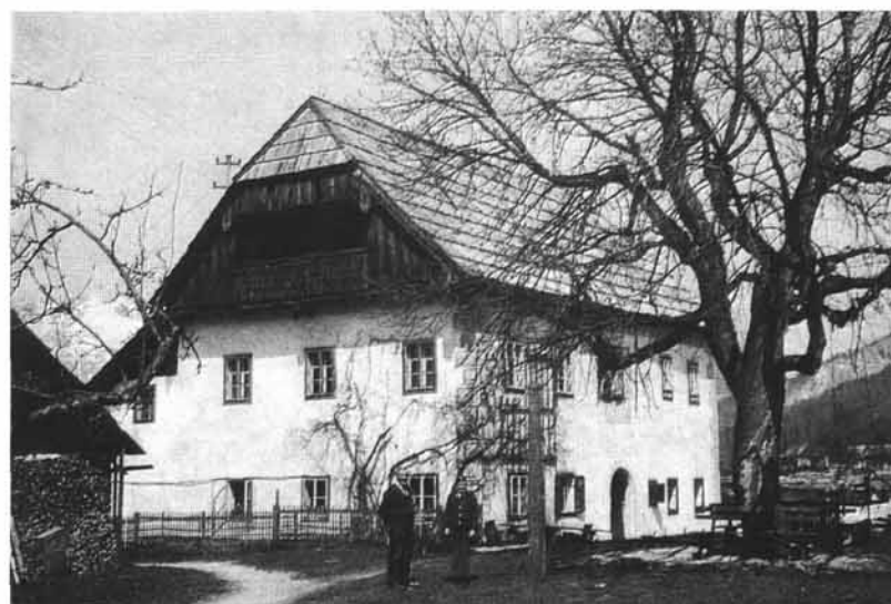
Abb. 6: Gerbmühle, Goisern, ganz ge- mauert, Torbogen aus rotem Marmor mit Jahreszahl 1600. Im Obergeschoß Doppel-Rund- bogenfenster mit schönem Eisen- gitter. Steiles Schopfdach, mit Brettern gedeckt. Gewandgang. War Sägemühle und wahr- scheinlich auch Gerberei. Statt- liches Bürgerhaus.
