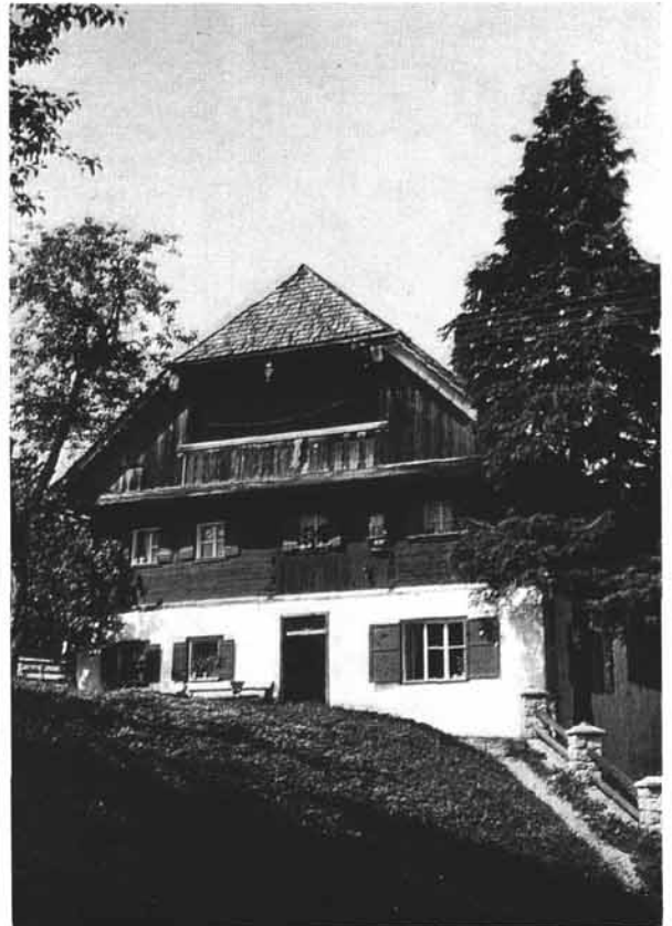
Abb. 9: Kleinbauernhaus in Draxlegg, Gemeinde Bad Ischl. Altes, schindelgedecktes, steiles Schopfdach. Haus durch Mauern unterfangen, Obergeschoß Blockbau. Gewandgang, Zierläden. Hausbaum. (Fenster in neuerer Zeit vergrößert.)
