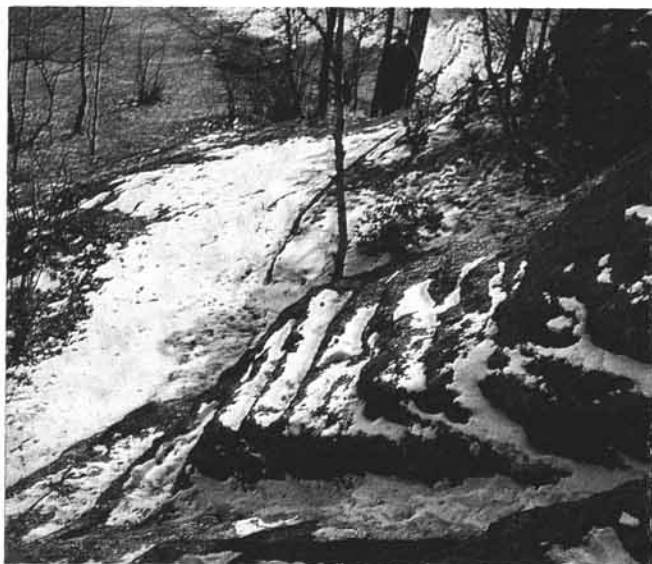
Abb. 6 Aufgang zur Höhe 738.00, Block II im Winter
