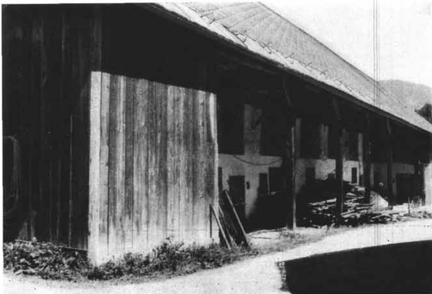
Abb. 3: Südfront des Stallgebäudes.
