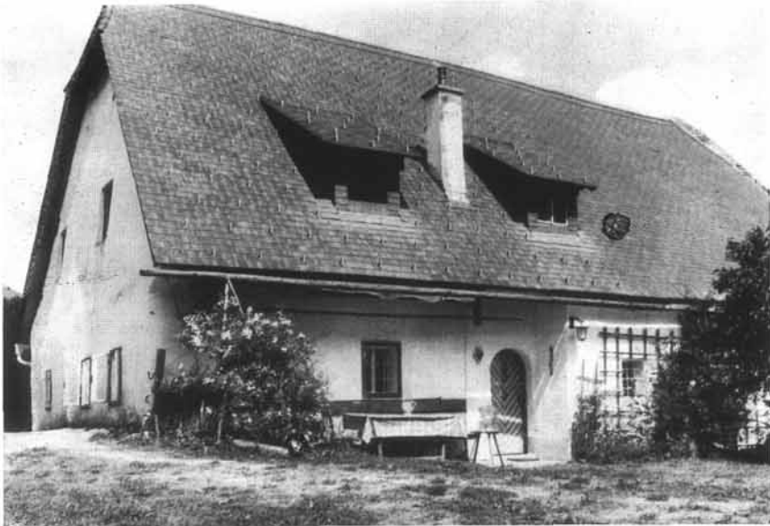
Abb. 2: Das Wohnhaus mit der bemerkens- werten Haustür und dem Jausenplatz unter dem breiten Vordach.
