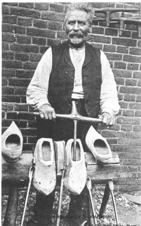
Der Holzschuhmacher in einer sorgfältig gestellten Aufnahme bei der Arbeit. Auf dem Holzbock stehen rechts und links je ein Schuh als fertiges Erzeugnis, davor angelehnt der Bohrrersatz. Drei weitere Drehgriffe hängen rechts oben an der Wand. (Dänische Postkarte ca. 1907.)
