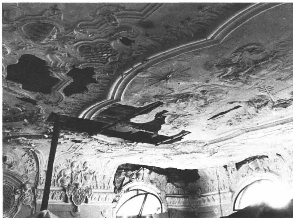
Reichersberg, Sakristei, Stuckdecke während der Restaurierung 1967.
