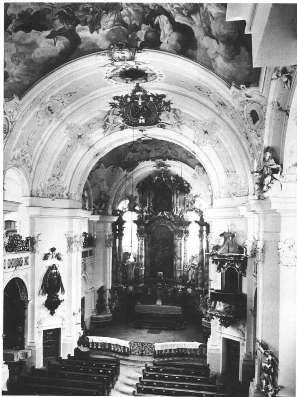
Suben, ehem. Stiftskirche, Innenansicht nach der Gesamtrestaurierung 1951 — 1953.
