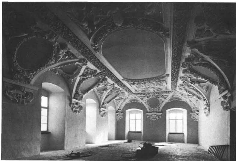
Reichersberg, Sommerrefektorium mit Stuck von G. B. Carlone von 1690, nach der Restaurierung 1972.
