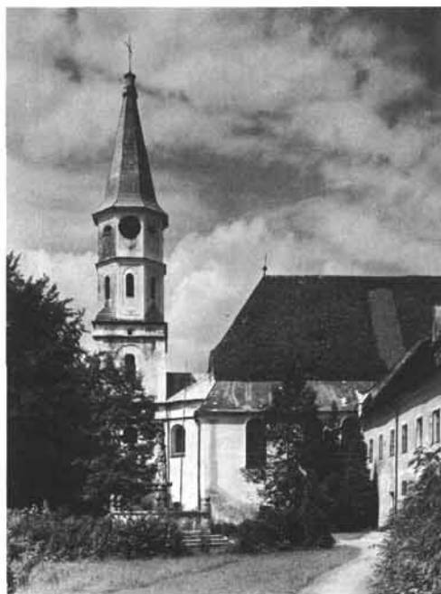
Ranshofen, ehem. Stiftskirche, Turm und Westteil von Süden.
