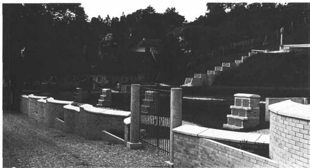
Der neue Friedhof mit Urnenhäusern und Schwingen der Umfassungsmauer aus gelbem Klinker und hellgrauen Betonabdeckungen
