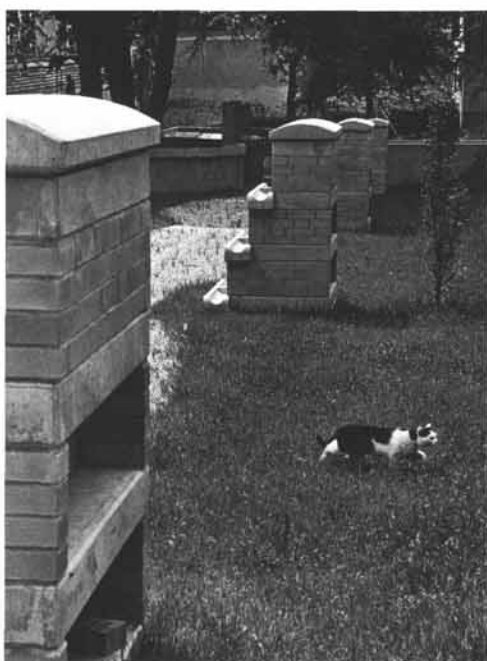
4 terrassenförmige Urnennischen-Häuser, Wände – gelber Klinker, Decken – Stahlbetonfertigteile
