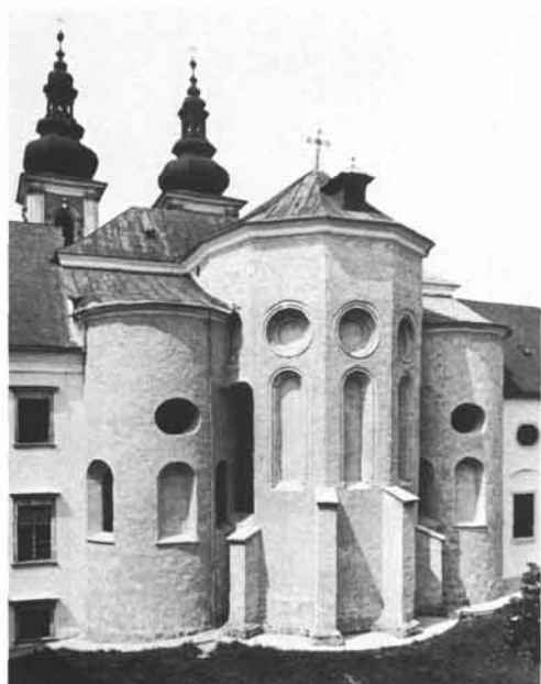
7. Apsis der Stiftskirche Kremsmünster von 1237 aus Kalktuff und Weißer Nagelfluh, aus der vor allem die Rahmen der Fenster und Oculi verfertigt wurden. Die beiden seitlichen Apsiden sind aus den gleichen Gesteinen erst 1614 angefügt worden (Foto Stift Kremsmünster).
