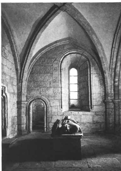
8. Südliches Luthaus der Stiftskirche mit Gunthergrabmal. Romanische und gotische Bauelemente aus Weißer Nagelfluh (Foto Bundesdenkmalamt).
