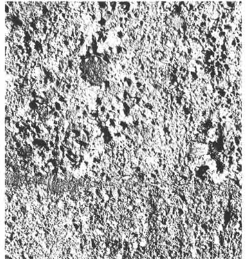
4. Weiße Nagelfluh mit dem Stockhammer bearbeitet, wobei die der natürlichen Löchrigkeit entsprechende rauhe Oberfläche erhalten bleibt (Foto H. Kohl).
