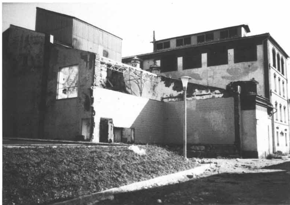
Das aufgerissene verflieste Sudhaus der stillgelegten Brauerei Mattighofen, die 1984 abgerissen wurde. Sie galt als Beispiel für eine moderne Fabriksarchitektur des späten 19. Jahrhunderts. Die Jalousien zeigen die erhöhte Lage des Kühlschiffes.
