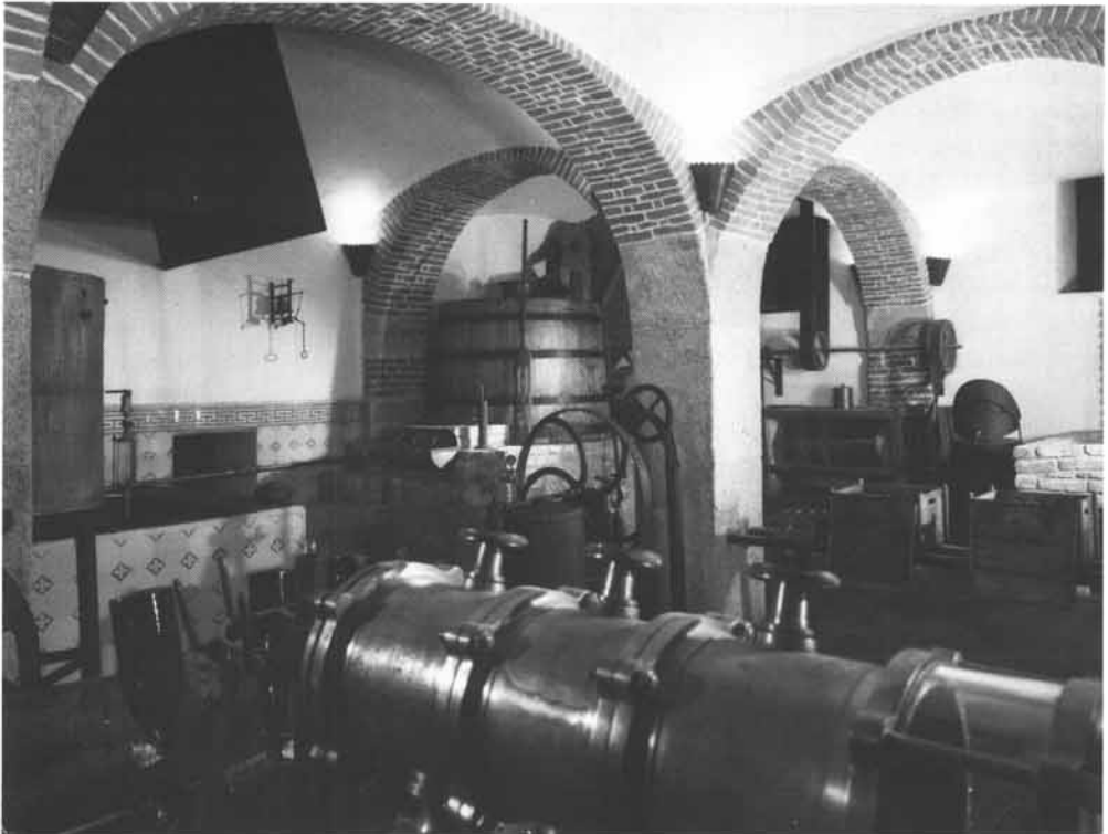
Blick in das Brauereimuseum in Linz, das in Kellerräumlichkeiten der Brau-AG untergebracht war: in der Mitte Maischbottich, Maischscheit und Grander, rechts hinten eine einfache Putzmaschine und im Vordergrund Geräte zur Flaschenbierzeugung.
