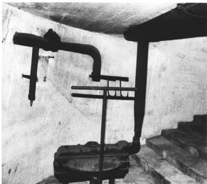
Winkelturm im Aluminiumwerk Ranshofen. Belüftungsanlage und Sitzstufen.
