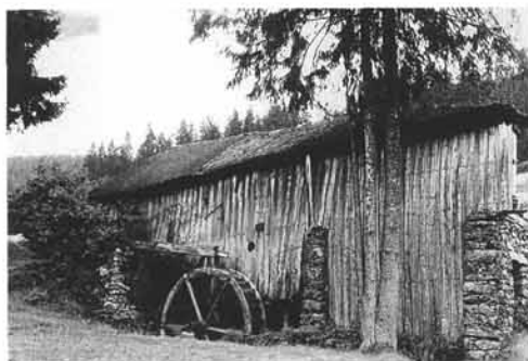
Hausmühle im nördlichen Haselgrabenbereich.
