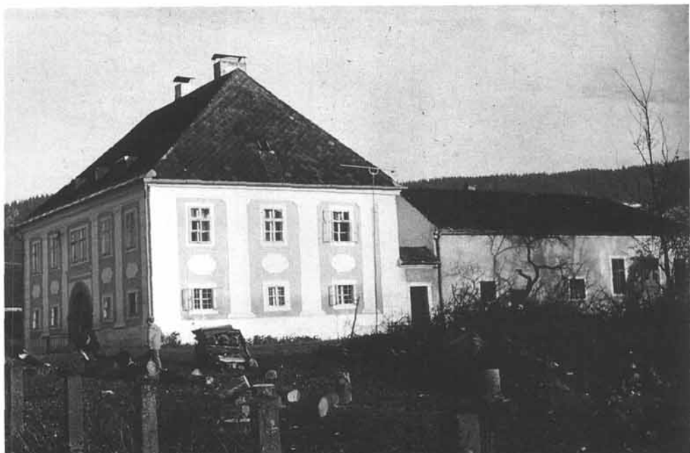
Pfarrhof mit ehemaligem Wirtschaftsgebäude vor der Generalsanierung des Pfarrhofes 1969 und der Abtragung des Wirtschaftsgebäudes 1970.
