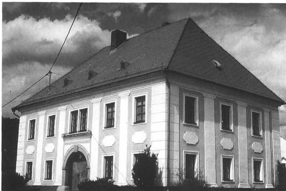
Pfarrhof St. Oswald bei Freistadt nach der Neueindeckung 1986.
