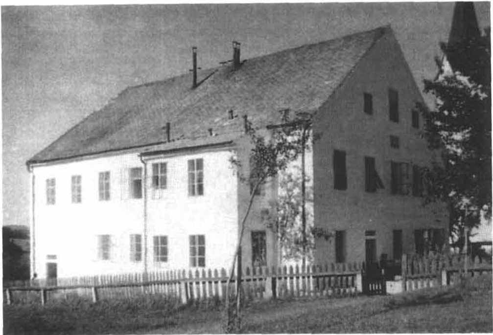
„Neues“ Schulhaus, für dessen ursprüngliche Gestalt der Bau im Sommer 1842 begonnen wurde, jetzt Mühlviertler Waldhaus/Waldmuseum. Foto: Archiv Heimathaus Freistadt
