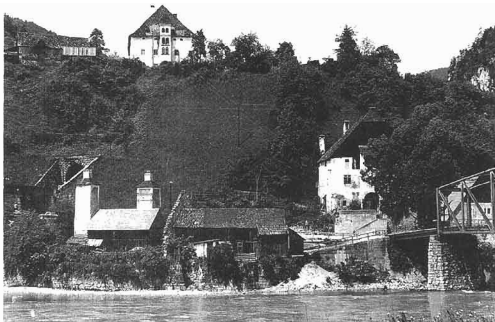
Abbildung 14: Laussa („Kessel“). Kesselhammer an der Einmündung des Laussabaches in die Enns (am linken Bildrand); links vorne Reste des Hammergebäudes mit zwei Eßkobeln, rechts vorne Verwaltungs- und Personalhaus, links oben Gewerksitz Schloß Kessel. Aufnahme: H. J. Köstler, Juni 1967.
