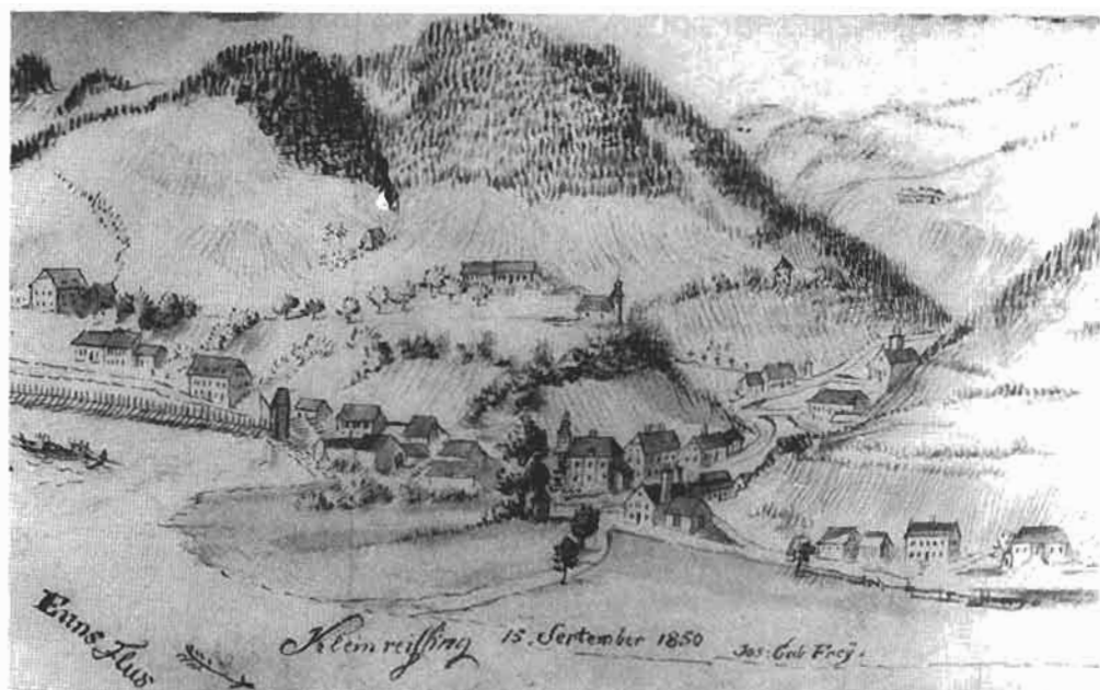
Abbildung 8: Kleinreifling. Gegend um die Einmündung des Kleinreiflinger Baches in die Enns, 1805; im Vordergrund der Vordere oder Wurschenhoferhammer (mit zwei Eßkobeln), hinten rechts der Hammer in der Not (Wurschenhofer-Gärbhammer). Fotoreproduktion einer mit „Kleinreifling 15. September 1850“ beschrifteten und signierten Zeichnung von Josef Gabriel Frey.
