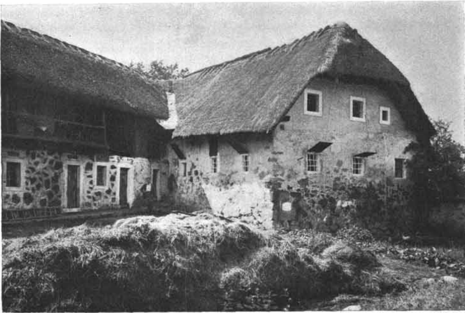
Abb. 2: Dasselbe Anwesen vom Hof aus. Blick vom Südosten.
