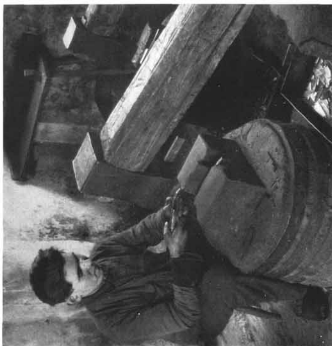
Baumerlschmiede, Abb. 3: Das Schneiden der Rlingen am Wefferhammer.
