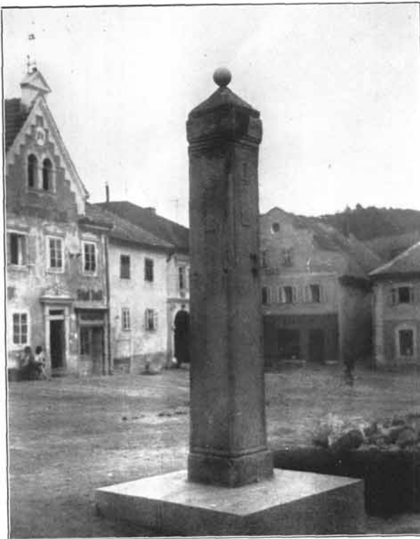
Abb. 2. Zell bei Zellhof: Pranger. 1925 als Hausbank aufgefunden, 1926 nach Ausbesserung auf neuem Sockel wiederaufgestellt.
