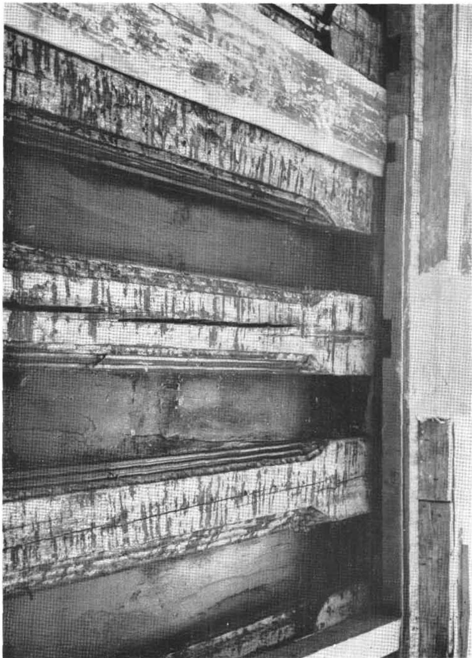
Balkendecke im Hause Hauptplatz 10, bereits gestützt (1958 abgetragen).
