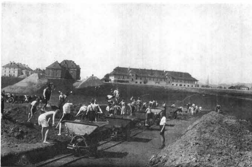
Bauarbeiten am „Arbeiterstadion“.
