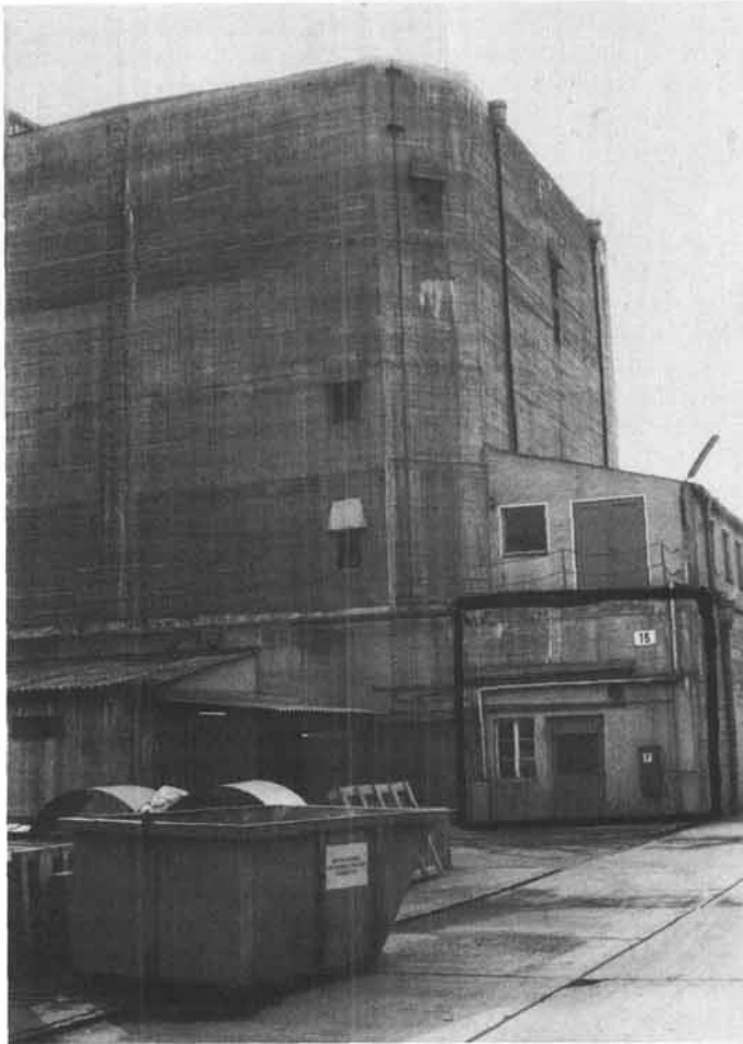
Abb. 2: Der große Hochbunker der Chemie Linz, unweit des Werkseinganges. Der stark umrandete Teil war seinerzeit nach vorne offen und für die Aufnahme eines Feuerwehrfahrzeuges bestimmt. Die übrigen Anbauten stammen aus der Nachkriegszeit. Fassungsraum etwa 2.500 Personen.
