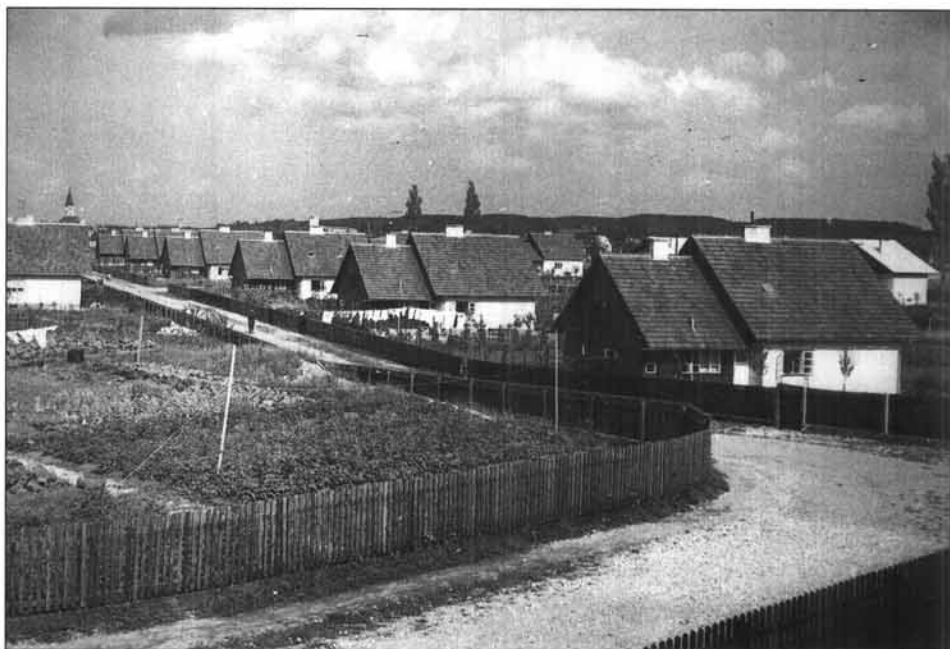
Abb. 2: Die „Fürsorgesiedlung“ in Schörghub. Zum Zwecke der Arbeitsbeschaffung sowie der Bekämpfung der Wohnungsnot errichteten private Bauunternehmen unter Mithilfe des freiwilligen Arbeitsdienstes und der künftigen Siedler auf Grundstücken, die die Stadt Linz unentgeltlich zur Verfügung stellte, von 1934–1937 240 Häuser für rund 1200 Menschen. Die Finanzierung dieses Projektes erfolgte durch den Bundes-Wohn- und Siedlungsfonds (Foto: ASiL, Dokumentation, Slg. Stenzel).
