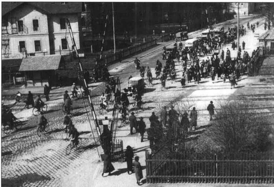
Abb. 1: Im Rahmen des Aufbau- bzw. Arbeitsbeschaffungsprogrammes sind in den Jahren 1935-1947 zahlreiche Bauvorhaben in Angriff genommen worden, so auch die Unterführung der Wiener Reichsstraße unter die Westbahntrasse. Im Bild die „Übersetz“ vor Beginn der Bauarbeiten. Im Hintergrund der Volksgarten (Foto: AStL, Dokumentation, Slg. Stenzel).
