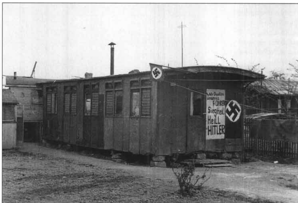
Abb. 16: Barackenlager Wegscheid. Als eine der vordringlichsten Aufgaben bezeichneten die neuen Machthaber die Beseitigung der Wohnungsnot und des schrecklichen Barackenelends in Linz (Foto: AStL, Dokumentation, Slg. Weidinger).
