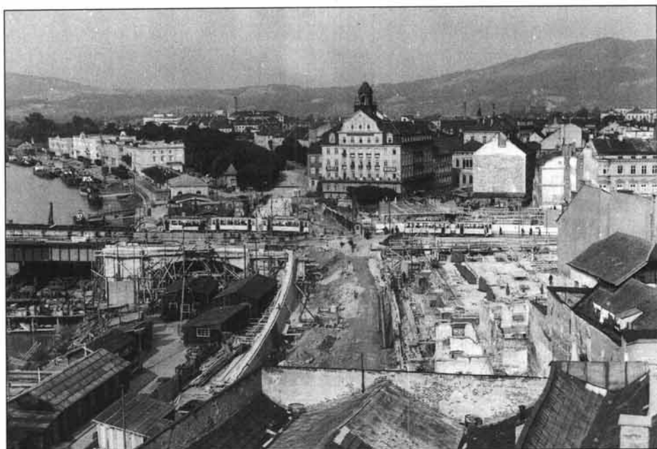
Abb. 13: Im Zusammenhang mit dem Brückenbau mußten wegen des Höhenunterschiedes besonders auf der Linzer Seite zahlreiche Häuser geopfert werden. Die in der Folge errichteten Finanzgebäude Ost und West bilden seither den nördlichen Abschluß des Hauptplatzes. Bildmitte: Das Hotel Weininger, in welchem Hitler bei seinen Besuchen in Linz nächtigte (Foto: AStL, Dokumentation, Slg. Stenzel).
