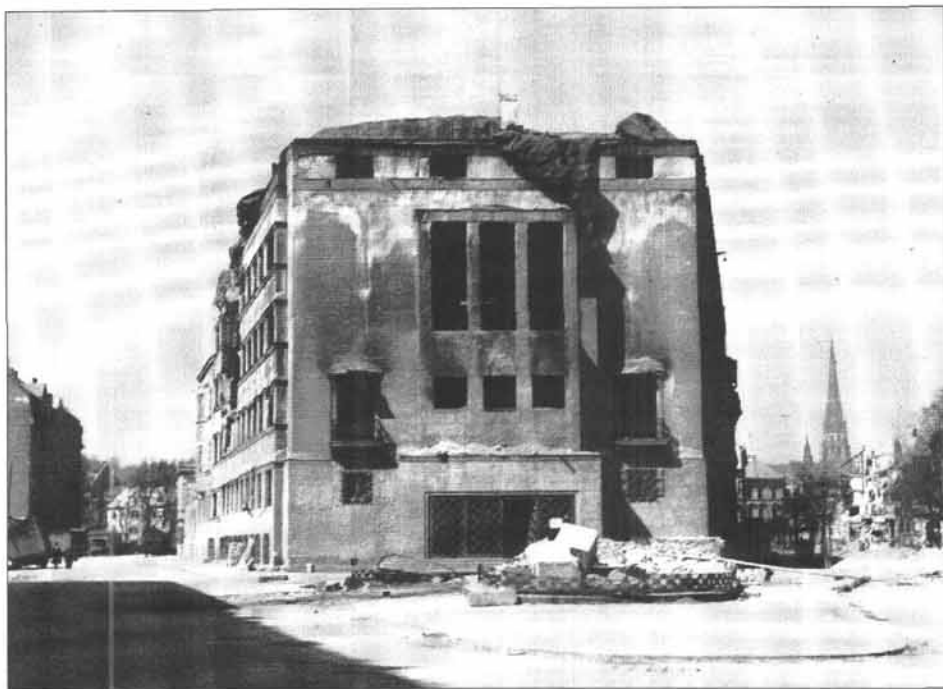
Abb. 4: Der erst nach den Einmarsch der Amerikaner vorsätzlich gelegte Brand verursachte noch größere Verwüstungen. Er zerstörte fast alle Räume des Hauptgebäudes, die gesamte innere Ausstattung, die Zwischenwände, Fenster, Türen, Fußböden und schließlich auch das Dachgeschoß (Foto: Alfred Grill, AKOÖA, Bildarchiv, A4001-A15).
