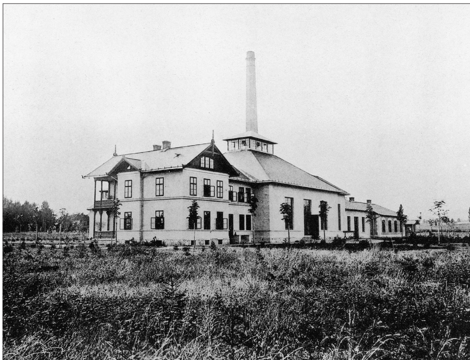
Abb. 28: Zwischen 1891 und 1894 schuf die Stadtverwaltung die erforderlichen Einrichtungen (Brunnen und Pumpstation in Scharlinz, Druckrohrleitungen, einen Hochbehälter nahe dem Guglhof und einen beim Gasthaus „Zum Jägermayr“, Verteilungsrohrnetz), um die Versorgung der Linzer Bevölkerung mit gesundem Trinkwasser sicherzustellen. Im Bild die Pumpstation Scharlinz (aus: Josef F. Heller, Die Wasserversorgung der Landeshauptstadt Linz. Linz 1894).
