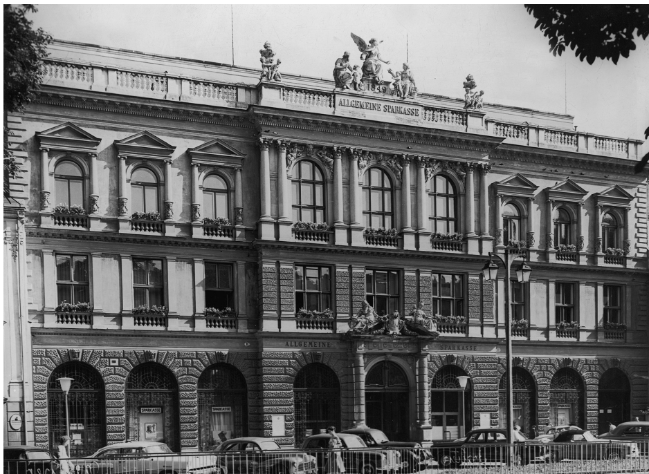
Abb. 7: Gebäude der Allgemeinen Sparkasse auf der Promenade um 1960 (Foto: Archiv der Allgemeinen Sparkasse Oberösterreich).
