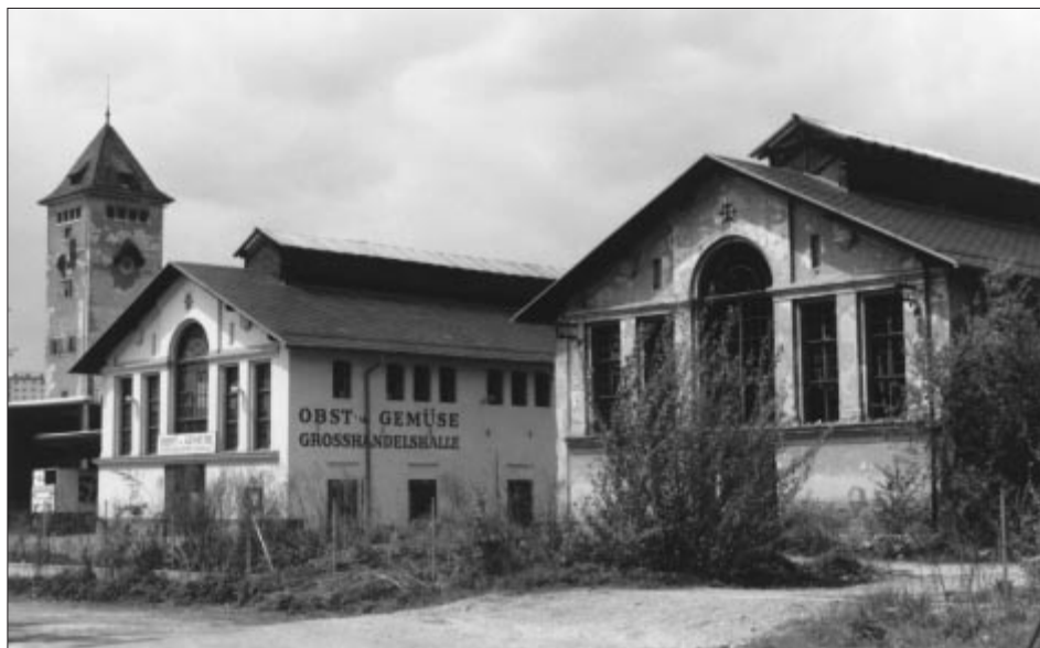
Abb. 3: Südfassade der beiden erhalten gebliebenen Kleinvieh- und Rinderschlachthallen des Grazer Schlachthofs von 1876, links der Wasserturm von 1915/17 (Foto: Helmut Lackner 1982).
