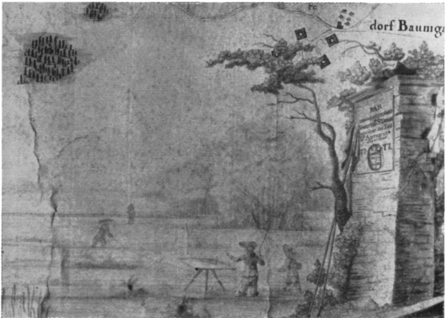
Bild 2. Mappa der Naarn-Niederung von Vaultrin. 1777. Darstellung der Vermessung mit Meßtisch und Meßkette im überschwemmten Gebiet.
