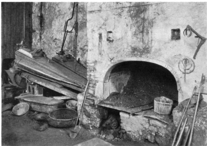
Garb- und Zainfeuer im Hammer von Prietal in Leonstein. 1910.
