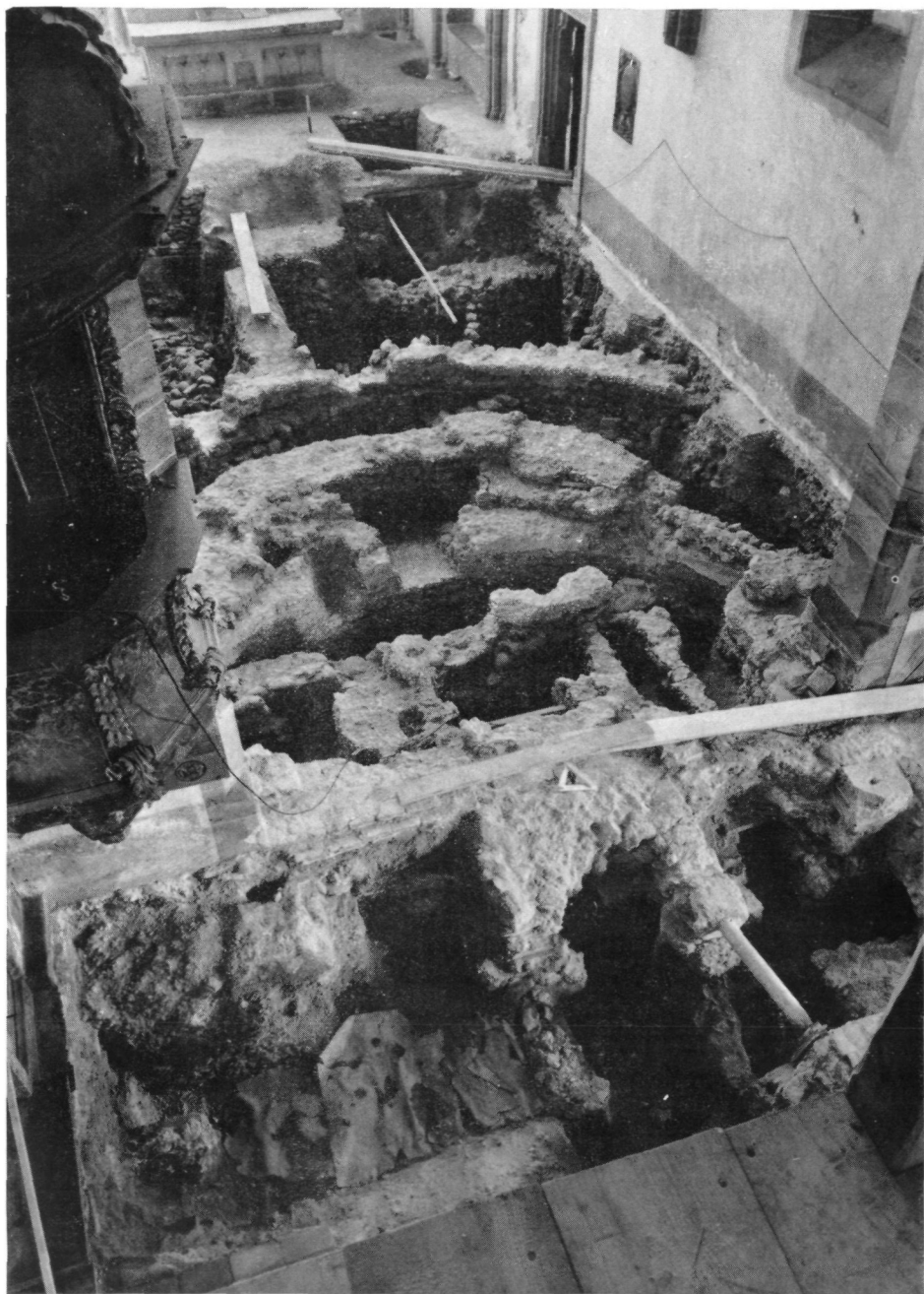
Presbyterium der St.-Laurentius-Kirche mit den Ostmauern der Vorgängerbauten und dem ältesten Hochaltar
