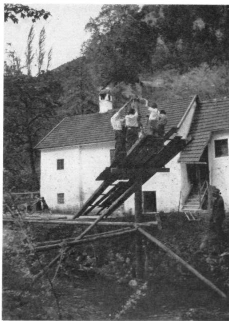
Abb. 9. Pilotenschlagen in Schmiedleiten, 1936
