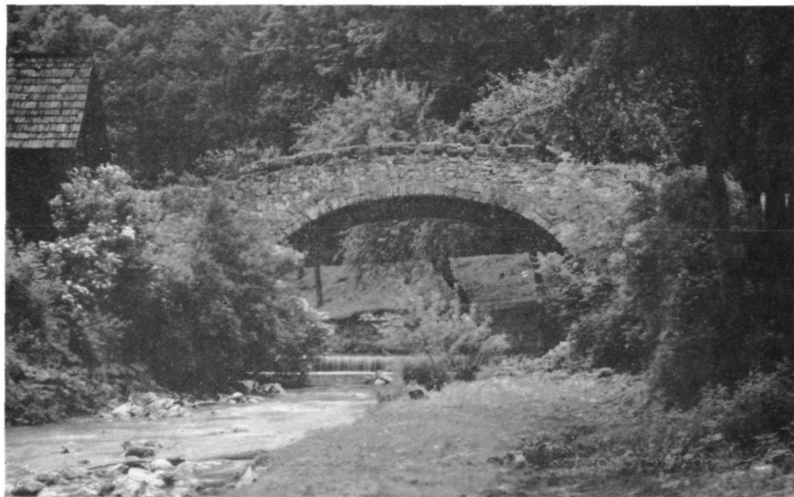
Abb. 2. Die Bogenbrücke im Zug der alten Landstraße
