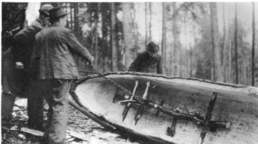
Abb. 10 "Prügl" mit "Sparrim" und Zwieselast zum Anbringen der Zugkette.
