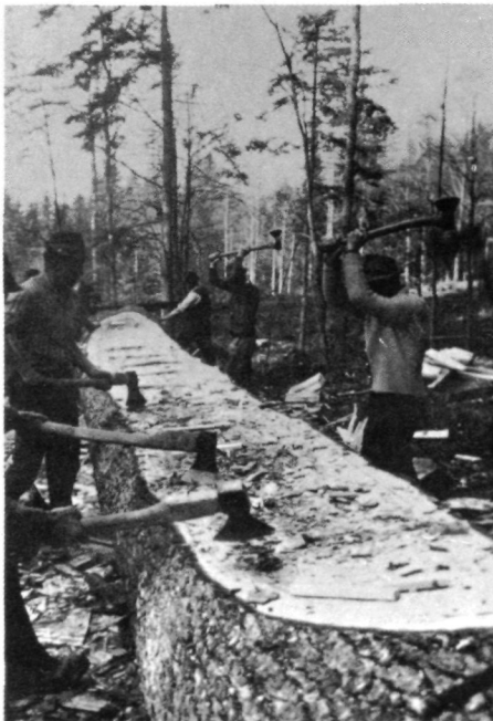
Abb. 5 "Kesselhacken" (zum Entfernen des Überholzes).
